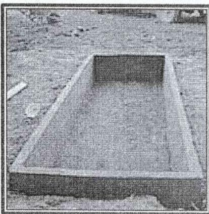
El piso de las cunas no requiere una cobertura de polietileno como se recomienda a menudo, pero cuando se emplean palas mecánicas es útil que las hileras de cunas tengan un piso de hormigón. Este debe ser un poco más ancho y más largo que la cuna (para una cuna de 1,80 por 3,60 m debería ser de 2 por 4 m) y estar a nivel (aunque el terreno tenga una leve pendiente) Otro dato a tener en cuenta es fabricar un marco para estandarizar la construcción de las plateas. Costo del contrapiso
