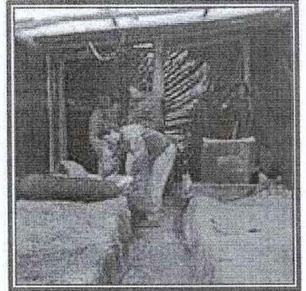
Tableros de 30 cm de ancho de chapa, madera (no es conveniente de ladrillos ya que no se pueden movilizar
